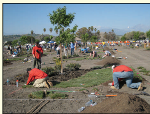
Patio Installation— Josh Long & Vinnie D'Alcotti
